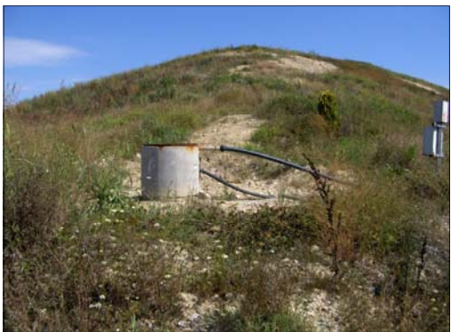
Pozzo per l'estrazione del percolato dal lotto 2 di discarica.
