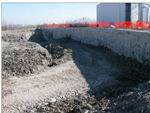
Porzione di diaframma realizzato a sud del Lotto 1.
