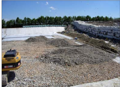
Stesa del sistema drenante sul fondo di una vasca
